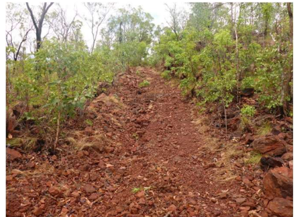
Access up Legune Hill_AFTER
